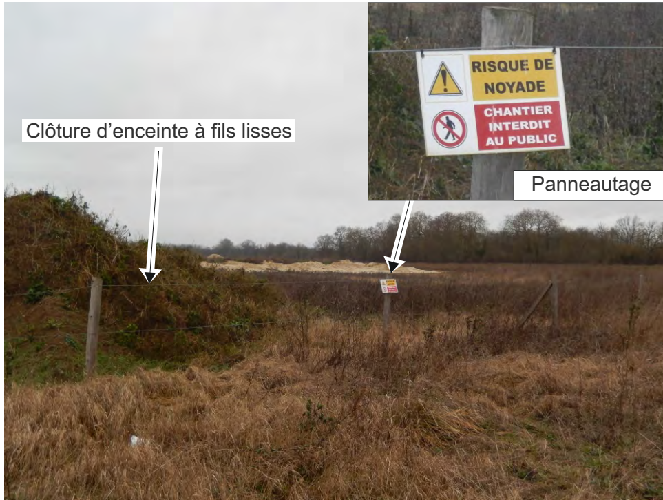
Clôture d'enceinte de la carrière et panneau
