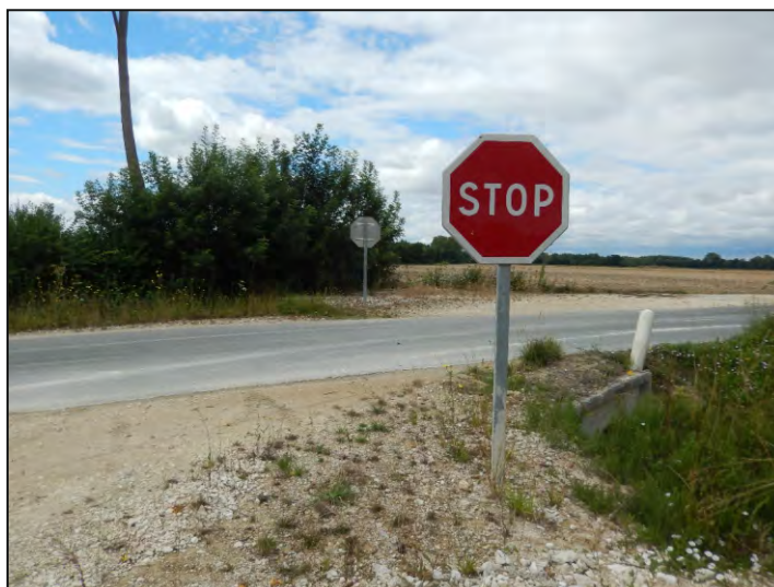
Panneaux « STOP » situés au niveau de la traversée de la RD82
